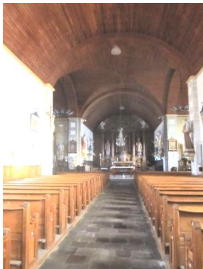
Vue intérieure de l'église Saint-Etienne de Bacilly
